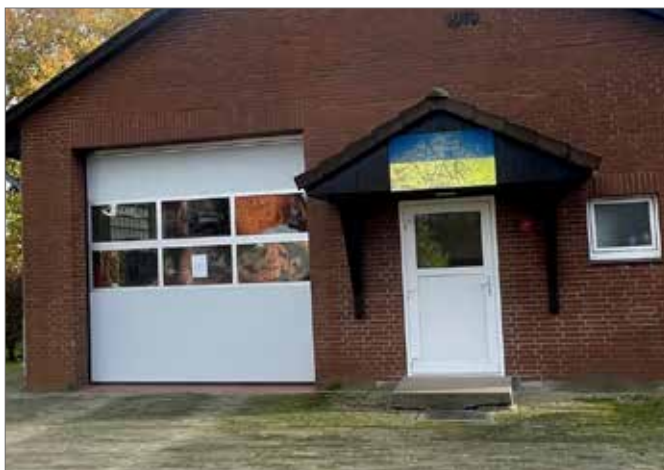
Das alte Tor ist gegen ein neues Sektionaltor ausgetauscht worden. Foto: Gemeinde Bienenbüttel
