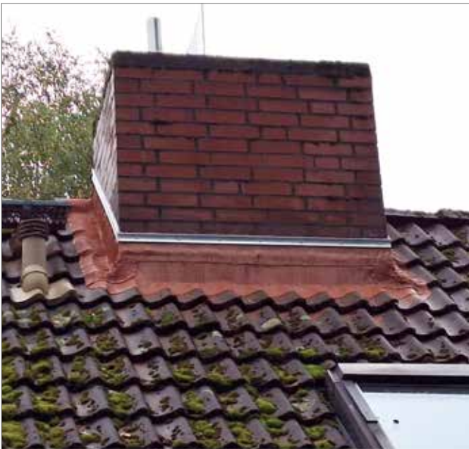
Am Schornstein hätte Wasser in das Hohnstorfer Dorfgemeinschaftshaus eindringen können. Durch eine neue Bleieinfassung ist der Anschluss am Dach nun wieder dicht. Foto: Gemeinde Bienenbüttel
