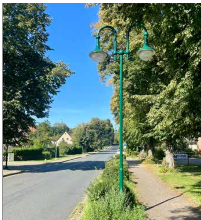
Die neuen LED-Doppelglockenleuchten sind so leistungsstark, dass sie auch die gegenüberliegende Straßenseite mit beleuchten. Foto: Gemeinde Bienenbüttel
